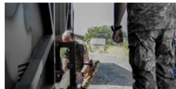
Stabilizzazione e messa in bolla (in piano) dello shelter
